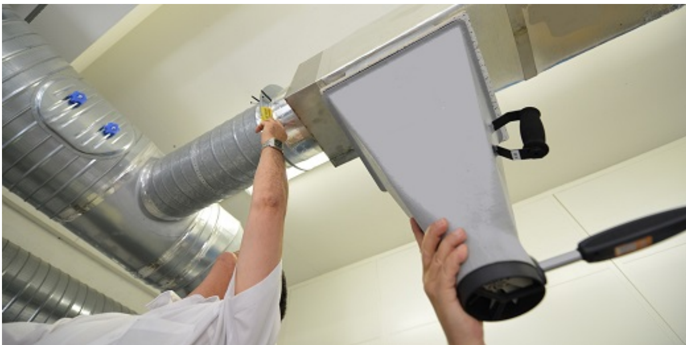
Travaux pratiques sur une plate-forme pédagogique aéraulique du CETIAT
